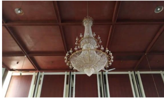
Gambar 6. Lampu Utama Masjid At-Taqwa Pekajangan
